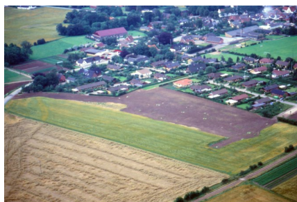
Fig. 5. Den sydligste del af "Findingevejen" ses som grænsen mellem det modne og det grønne korn i det område, som nu dækkes af parcelluse. I nederste højre hjørne ses leddet, hvor vejen skærer jernbanen; standerne fra advarselsskiltene kan stadig ses på stien. Foto: Mogens Bo Henriksen 1988.
